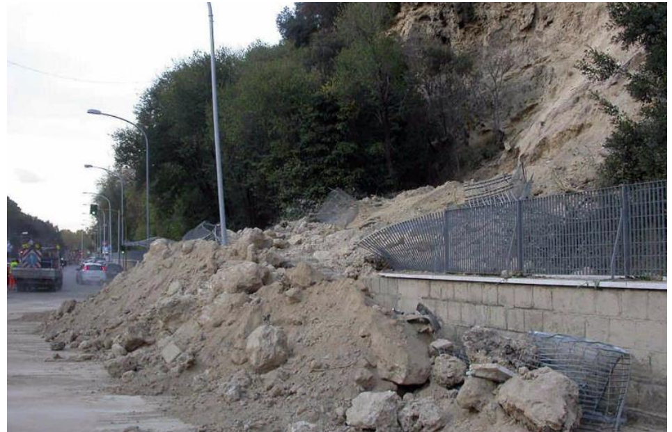
Frana Viale Tiziano novembre 2008
