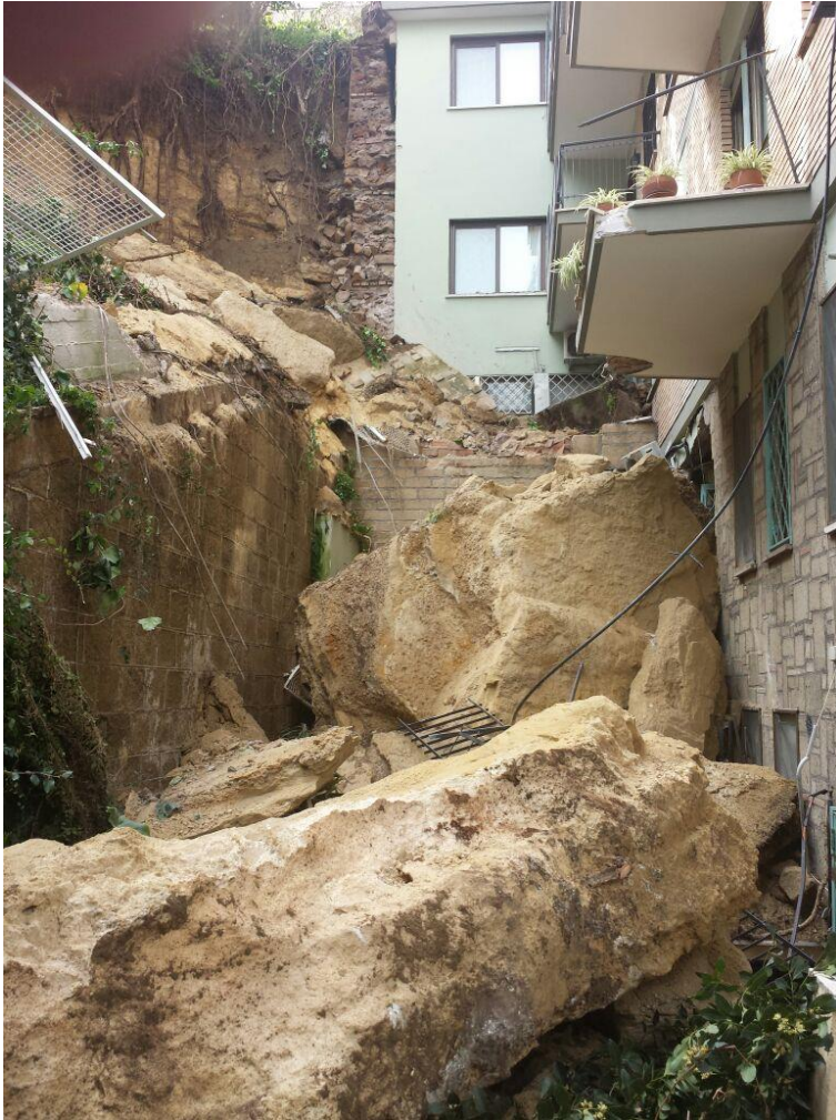
Frana Via Dell'Ongaro marzo 2015
