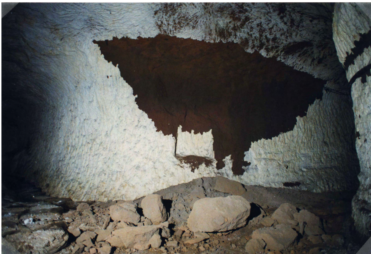
Fig. 3 - Fenomeni di crollo all'interno della rete caveale. - Underground cavity collapse.
